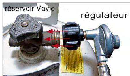
Ouvrir le gaz vers le brûleur et faire des essais d'étanchéité avec une solution d'eau savonneuse.
